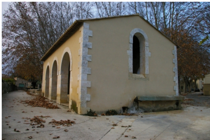
Face latérale avec arrivée du canal extérieur d'alimentation en eau et face principale © Jennifer Gomez (2007).
