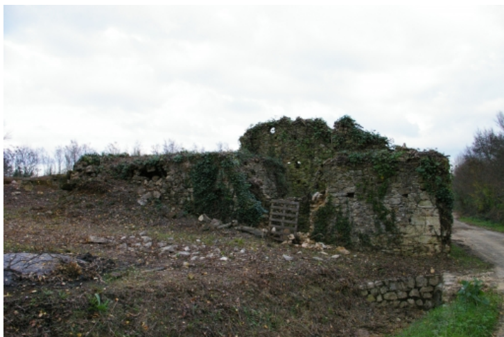
Angle Sud ouest du moulin à eau, vue depuis la voie communale © LOINTIER Philippe (2004).
