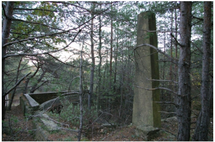
Bassins de décantation © Jennifer Gomez (2007).
