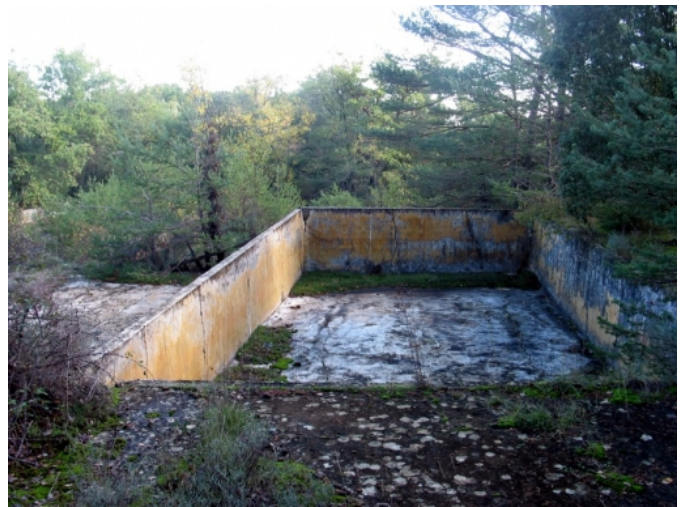
Bassin de décantation © Jennifer Gomez (2007).
