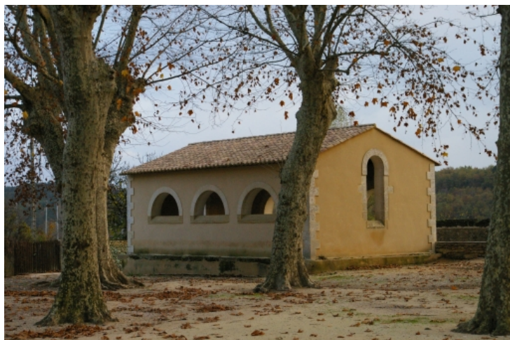
Face arrière avec canal extérieur d'alimentation en eau et face latérale © Jennifer Gomez (2007).
