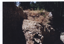
Détail. Détail Pont de la Tave
