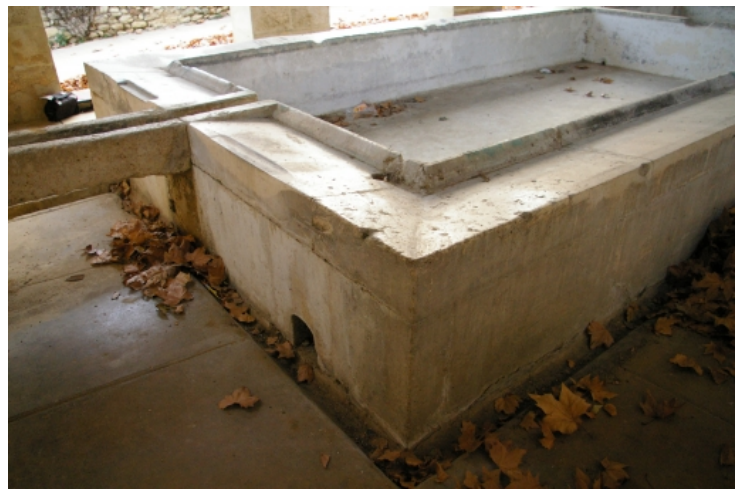
Canal d'arrivée d'eau, bassin et rigole d'évacuation. © Jennifer Gomez (2007).
