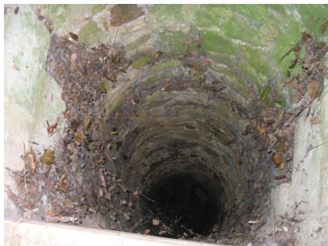
Intérieur du puits © Jérôme Veyrat (2007).
