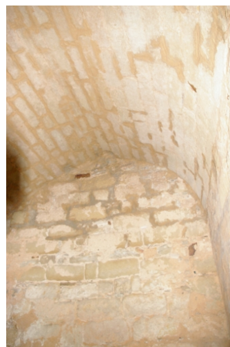
Intérieur du réservoir, voûte d'ogive
