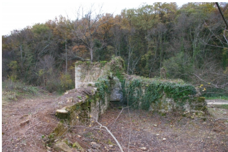
Entrée de l'écluse au nord © LOINTIER Philippe (2004).
